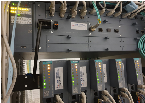
SCALANCE SC632 – Il Firewall Industriale che garantisce la sicurezza della comunicazione dalla rete dello stabilimento all'IT e viceversa.
